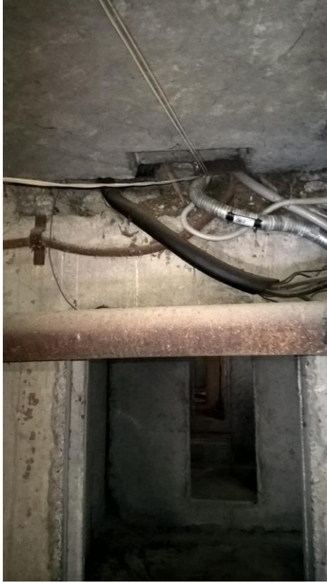
Фото 3. Прокладка магистралей в подвале
