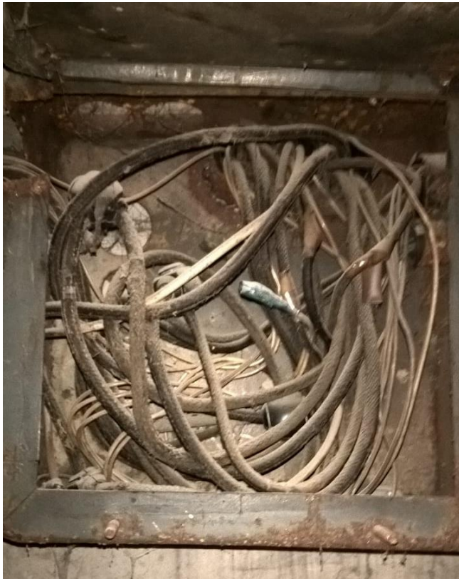
Фото 4. Ответвление магистрали на стояк
