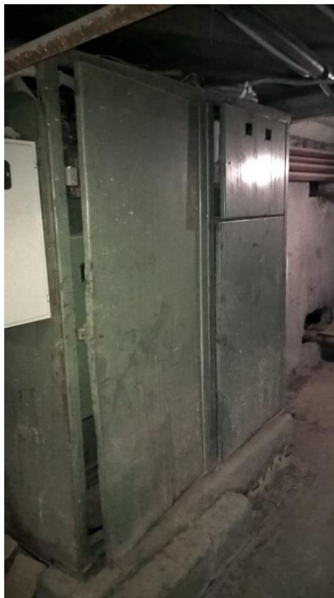
Фото 2. Размещение щита ВРУ в подвале
